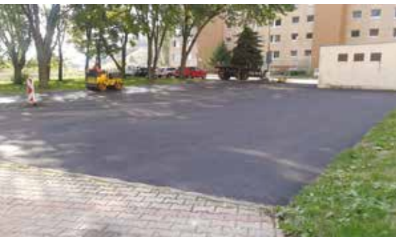
Rekonštrukcia parkoviska Galandova 22 10 939 €
