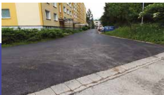
Rekonštrukcia komunikácie na Ul. Severná 14 909 €
