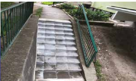
Rekonštrukcia schodišť a rozšírenie parkovísk na ulici Jilemnického 8 800€
