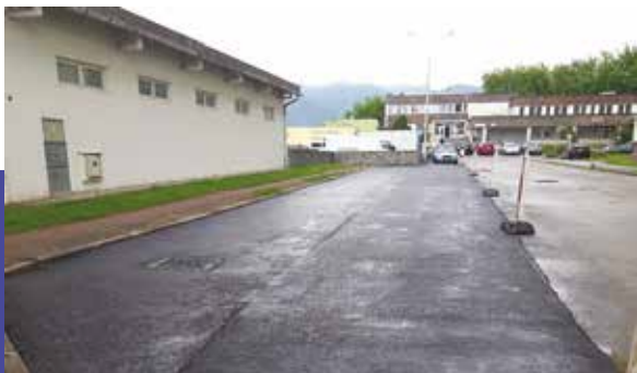
Rekonštrukcia parkovísk na Ul. Hurbanova, Hodžova a Štefunku 39 990 €
