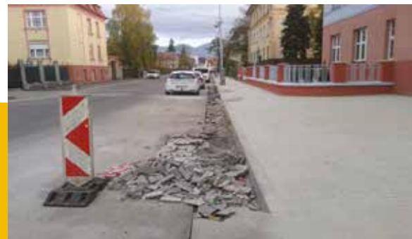
Rekonštrukcia časti chodníka Kuzmányho 44 411 €
