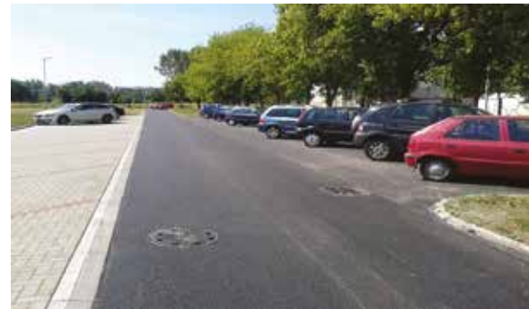
Rekonštrukcia časti komunikácie A.Stodolu 22 141 €
