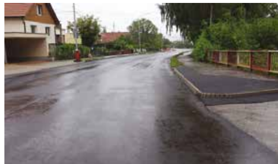
Rekonštrukcia komunikácie na Ul. Hollého 145 336 €
