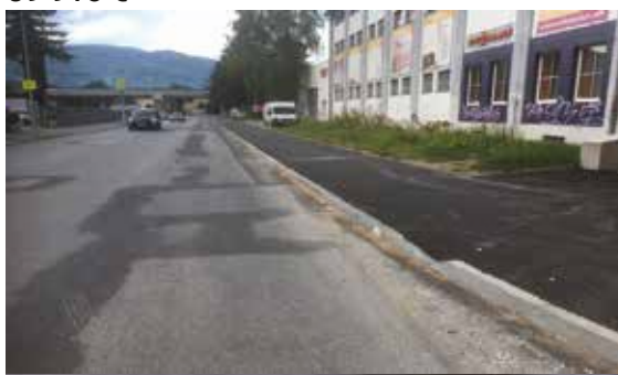
Rekonštrukcia chodníka na Ul. Čsl. armády 39 915 €
