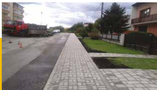
Rekonštrukcia chodníka Poničanova 36 872 €
