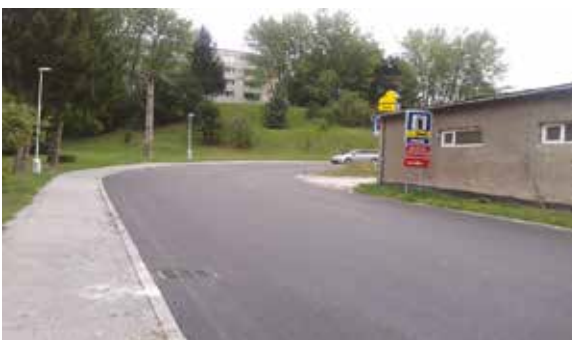
Rekonštrukcia časti komunikácie Stavbárska 118 967 €
