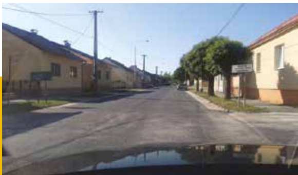
Rekonštrukcia časti komunikácie Medňanského 67 840 €
