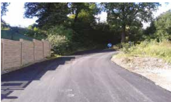
Rekonštrukcia časti komunikácie Záturčianska – Kaštieľ 55 795 €
