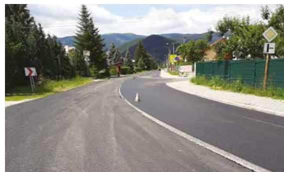
Rekonštrukcia komunikácie na Ul. Kolónia Hviezda 226 452 €
