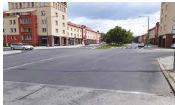
Rekonštrukcia komunikácie na Ul. Červenej armády 107 691 €
