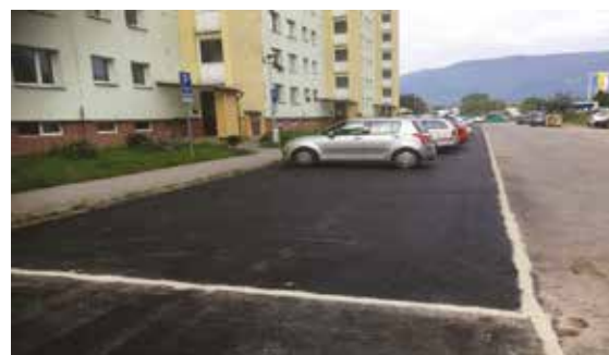
Rekonštrukcia parkoviska na Ul. Hodžova 16 519 €
