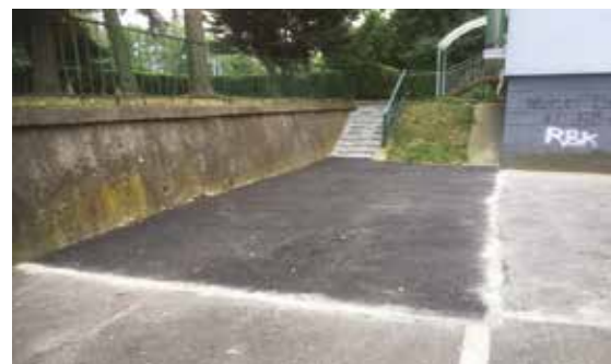
Obnova schodov a rekonštrukcia parkovísk na Ul. Jilemnického 21-27 15 143 €
