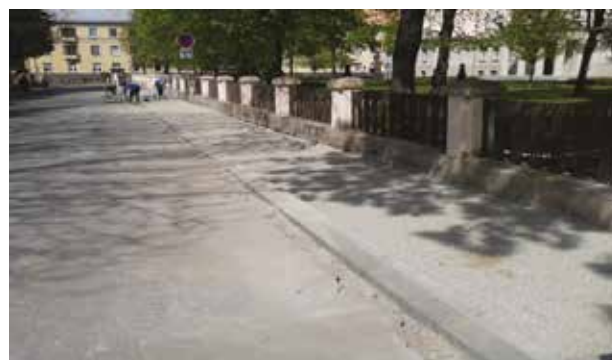
Rekonštrukcia chodníka Hroboňova 15 818 €
