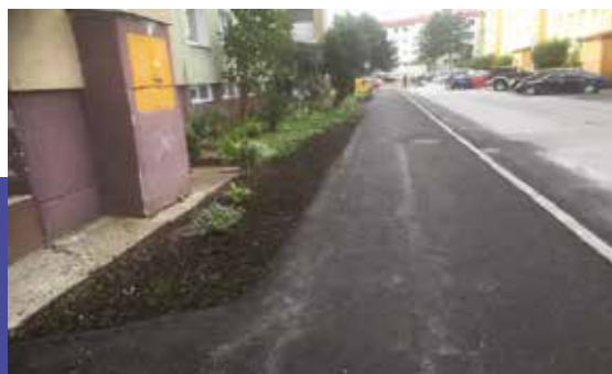
Rekonštrukcia chodníka na Ul. Hurbanova 20 831 €
