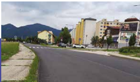
Rekonštrukcia komunikácie na Ul. Dúbravca 176 983 €
