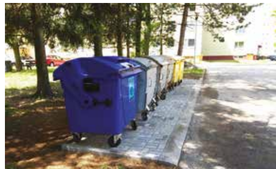
Rekonštrukcia stojiska na odpady na Ul. Kronera 2 311 €
