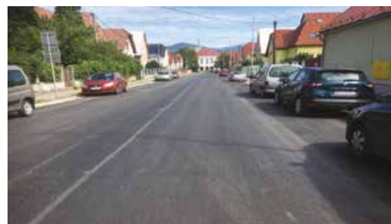
Rekonštrukcia komunikácie na Ul. Hečkova 70 586 €
