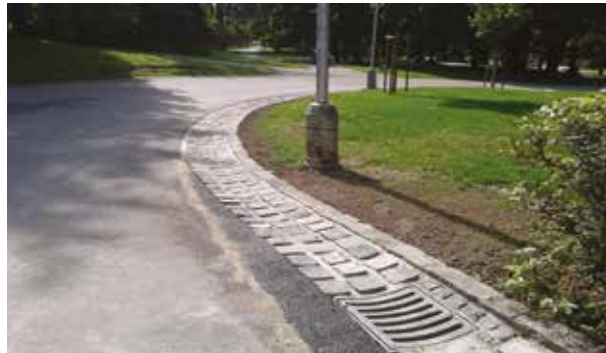
Rekonštrukcia rigolu M.Hora 29 900 €
