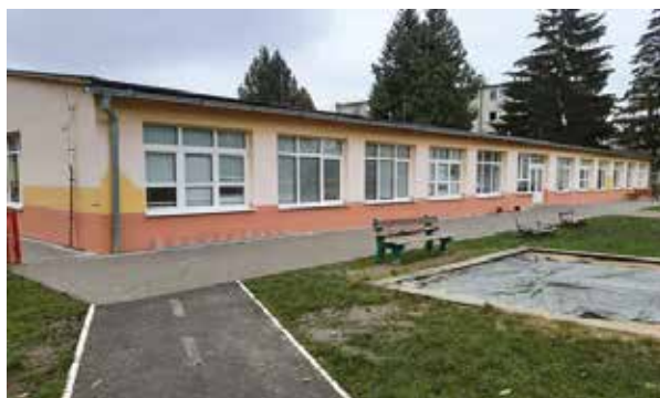
Sanácia obvodového plášťa MŠ na Tajovského ulici v Martine - II. Etapa 51 986 €
