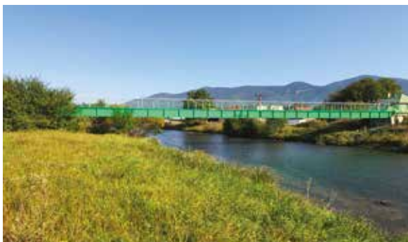
Rekonštrukcia spodnej nosnej časti a výdrevy pešej lávky cez Turiec 23 683 €
