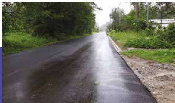
Obnova cestného rigolu na Ul. Hrdinov SNP 22 734 €
