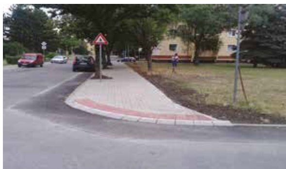
Rekonštrukcia chodníka Tomášikova 16 954 €
