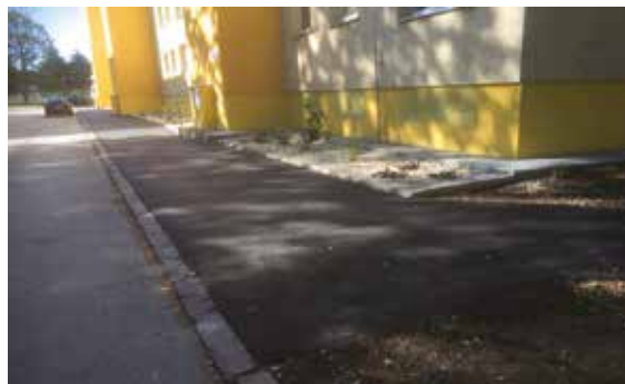
Oprava chodníka na Ul. Gogoľova 7 415 €
