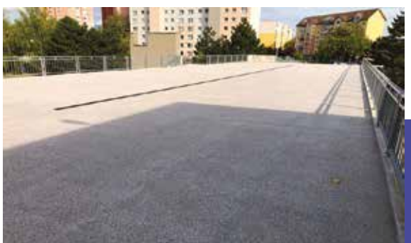
Rekonštrukcia nadchodu na ulici N.Hejnej - Ladoveň 112 000 €
