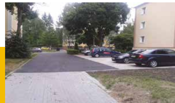
Rekonštrukcia parkoviska Jilemnického 13 16 699 €
