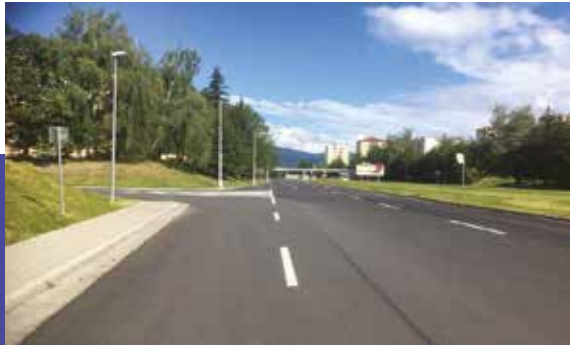
Rekonštrukcia komunikácie na Ul. Nadi Hejnej 196 108 €
