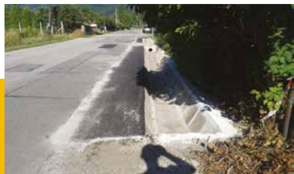
Rekonštrukcia časti rigolu Hrdinov SNP 7 350 €
