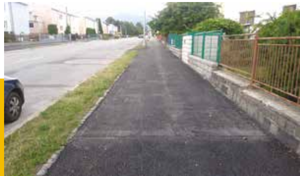
Rekonštrukcia chodníka Hollého 45-51 8 487 €
