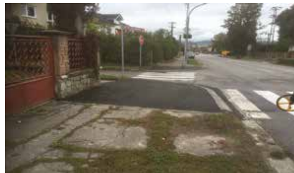
Oprava bezbariérových vstupov na chodníku na Ul. Hollého 7 845 €
