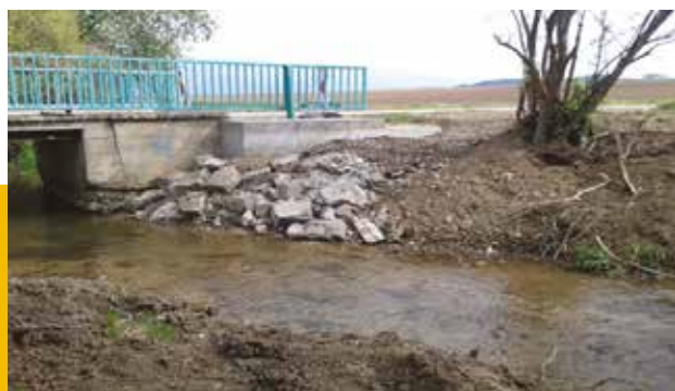
Rekonštrukcia opornej časti mosta M. Bôrová 10 000 €
