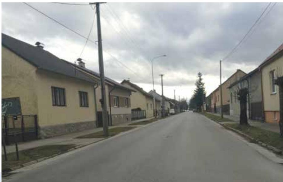
■ Oprava Ulice Medňanského
