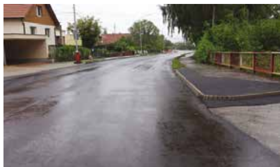
Rekonštrukcia komunikácie na Ul. Hollého 145 336 €
