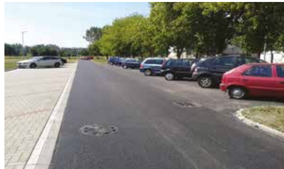
Rekonštrukcia časti komunikácie A.Stodolu 22 141 €
