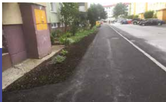
Rekonštrukcia chodníka na Ul. Hurbanova 20 831 €
