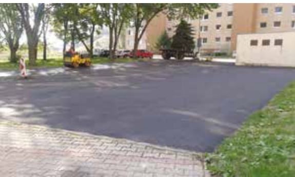
Rekonštrukcia parkoviska Galandova 22 10 939 €
