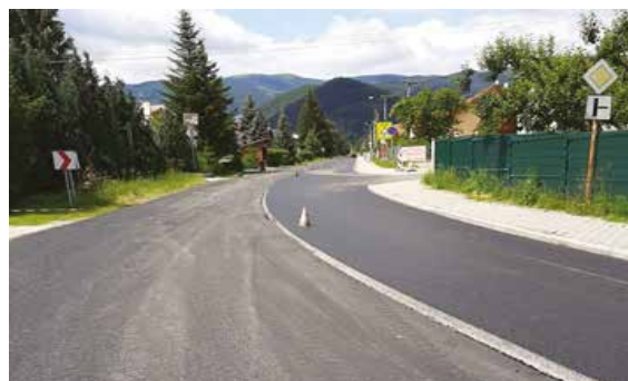
Rekonštrukcia komunikácie na Ul. Kolónia Hviezda 226 452 €
