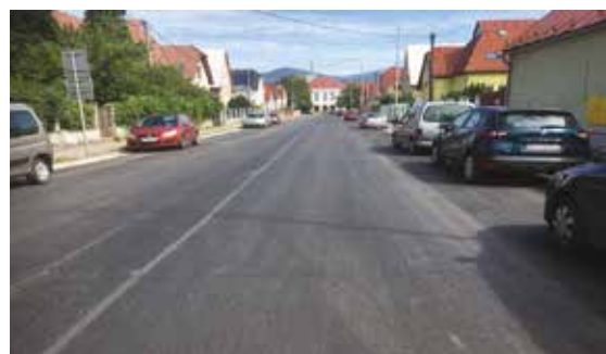
Rekonštrukcia komunikácie na Ul. Hečkova 70 586 €
