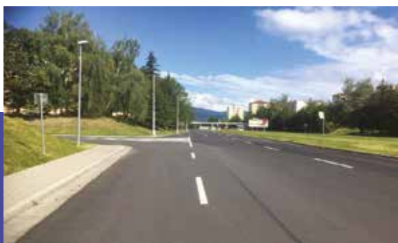
Rekonštrukcia komunikácie na Ul. Nadi Hejnej 196 108 €
