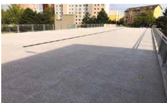
Rekonštrukcia nadchodu na ulici N.Hejnej - Ľadoveň 112 000 €
