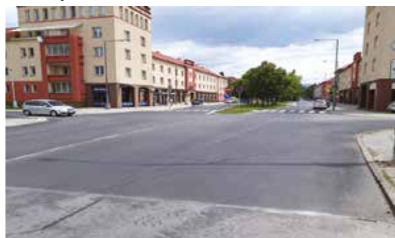
Rekonštrukcia komunikácie na Ul. Červenej armády 107 691 €
