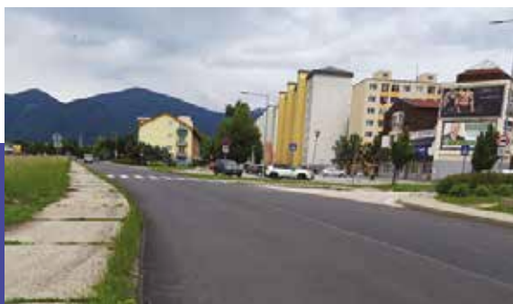
Rekonštrukcia komunikácie na Ul. Dúbravca 176 983 €
