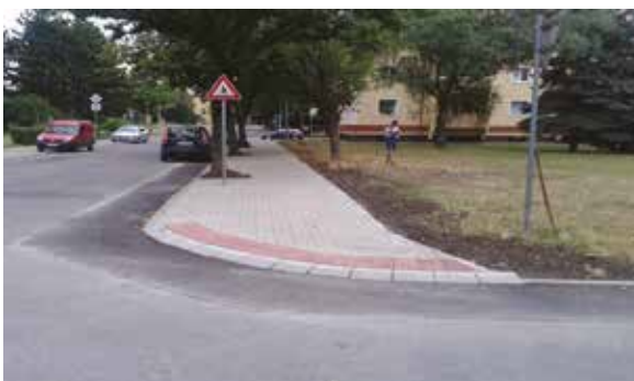
Rekonštrukcia chodníka Tomášikova 16 954 €
