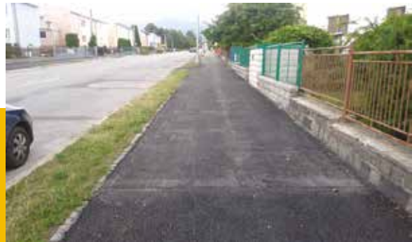
Rekonštrukcia chodníka Hollého 45-51 8 487 €
