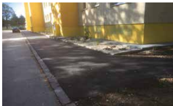
Oprava chodníka na Ul. Gogoľova 7 415 €
