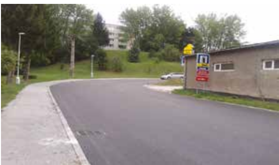
Rekonštrukcia časti komunikácie Stavbárska 118 967 €
