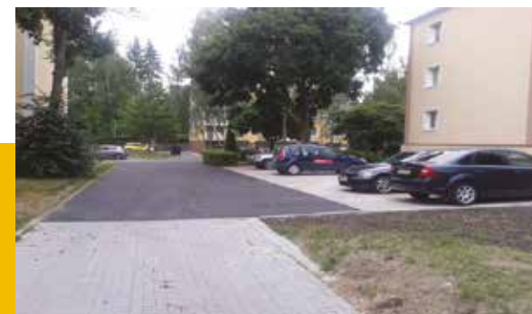
Rekonštrukcia parkoviska Jilemnického 13 16 699 €
