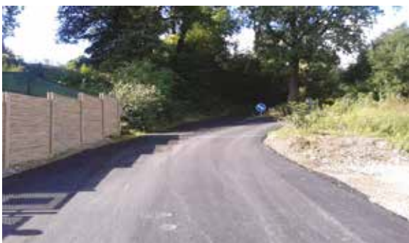
Rekonštrukcia časti komunikácie Záturčianska – Kaštieľ 55 795 €
