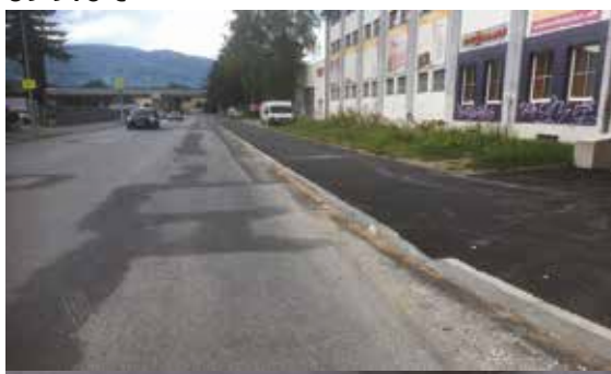
Rekonštrukcia chodníka na Ul. Čsl. armády 39 915 €
