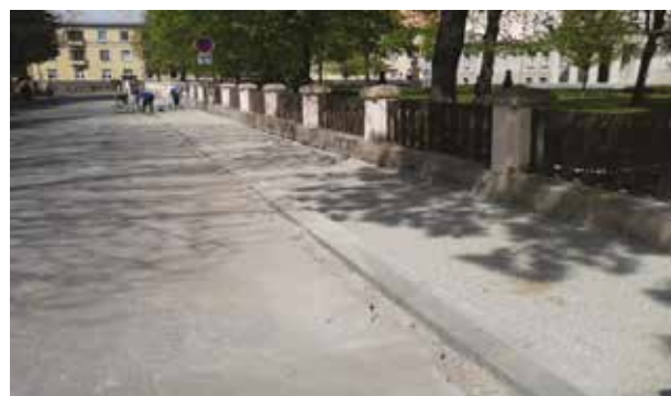
Rekonštrukcia chodníka Hroboňova 15 818 €
