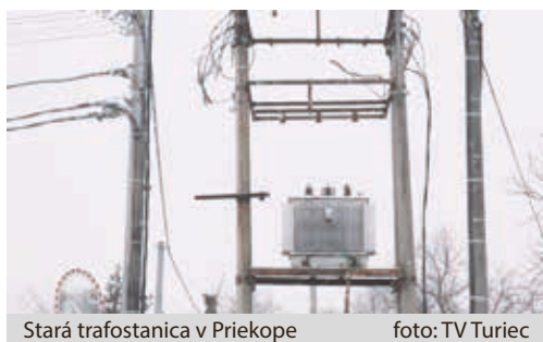
Stará trafostanica v Priekope foto: TV Turiec
