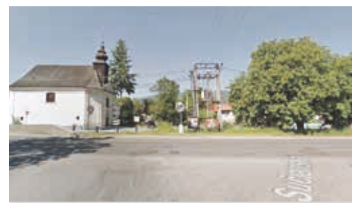
Rekonštruované vedenia v Priekope foto: TV Turiec
