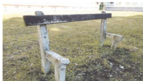
Poškodené lavičky čaká renovácia
