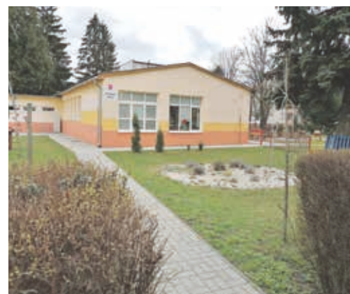
Na budove MŠ, Tajovského bolo odstránené vlhnutie budovy a súčasne sa zrekonštruovali príslušné chodníky foto: autor
