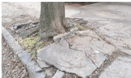
Korene stromov poškodili asfalt na Ul. P. O. Hviezdoslava
