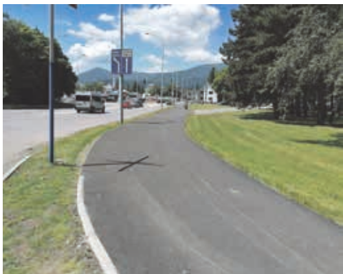
Obnovený chodník na Ul. Kohútovej foto: autor
