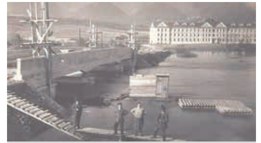
Výstavba mostu zdroj: SNK Martin, Igor Dobrovolný
