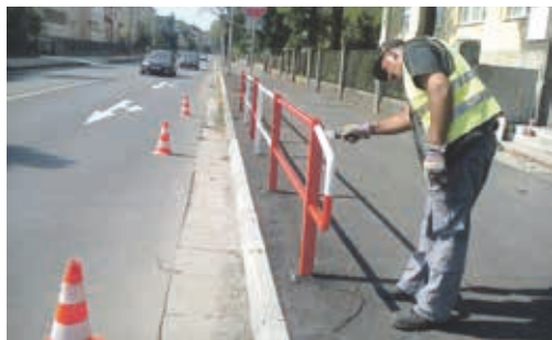
Nové bezpečnostné zábradlie pred Živenou foto: archív BH
