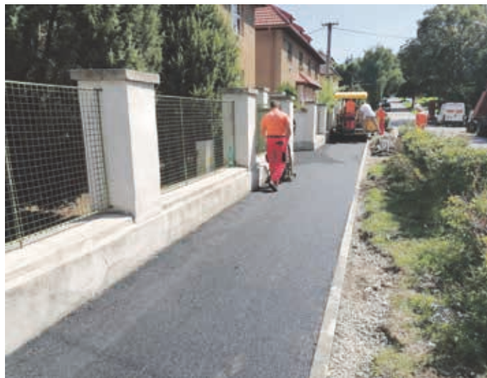
Obnova chodníka na Ul. V. P. Tótha
