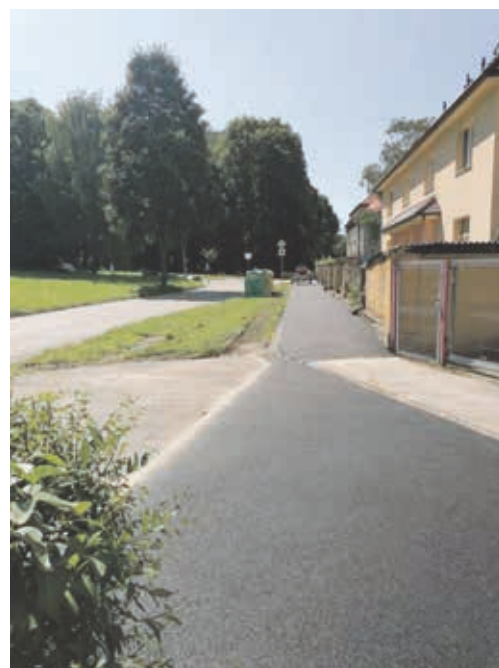
Obnovený chodník na Ul. Holubyho
