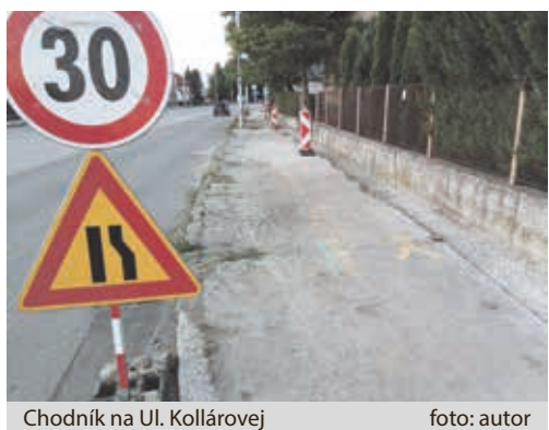
Chodník na Ul. Kollárovej foto: autor
