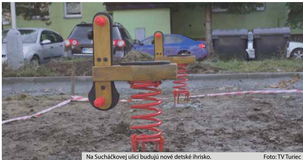
Na Sucháčkovej ulici budujú nové detské ihrisko.
