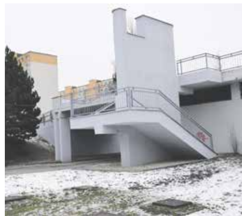
Vlni bolo zrenovované bočné schodisko na moste na Ul. N. Hejnej. Foto: Roman Kopka
