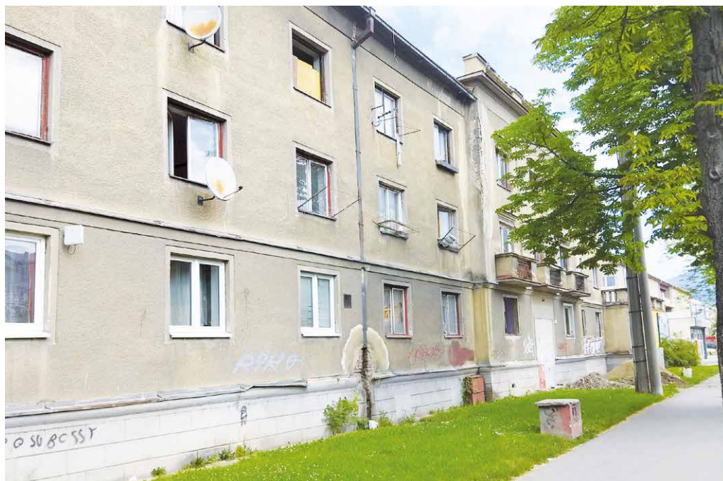
Táto bytovka na Ulici Ambra Pietra bola postavená v šesťdesiatych rokoch minulého storočia. Foto: Roman Kopka
