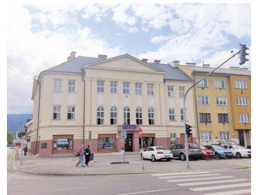
Po rekonštrukcii exteriéru budovy nasleduje aj renovácia vnútrajška. Foto: Roman Kopka
