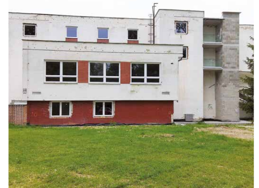
Interiér budúceho sídla CVČ Kamarát je už zrenovovaný. Počíta sa aj so zateplením budovy. Foto: Roman Kopka
