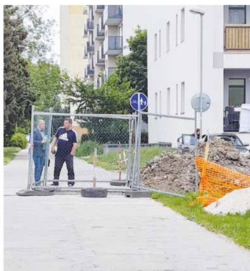
Rekonštrukciu tepelných okruhov si Priekopčania už všimli. Deje sa im rovno pod oknami. Foto: Jana Cikhartová
