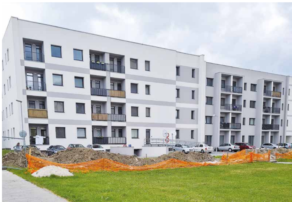
Niektoré práce na rekonštrukcii siete sa už vykonávajú. Foto: Jana Cikhartová
