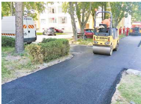
Na Tajovského ulici zrekonštruovali celý chodník aj s novými bezbariérovými nájazdmi. Foto: Bruno Horecký
