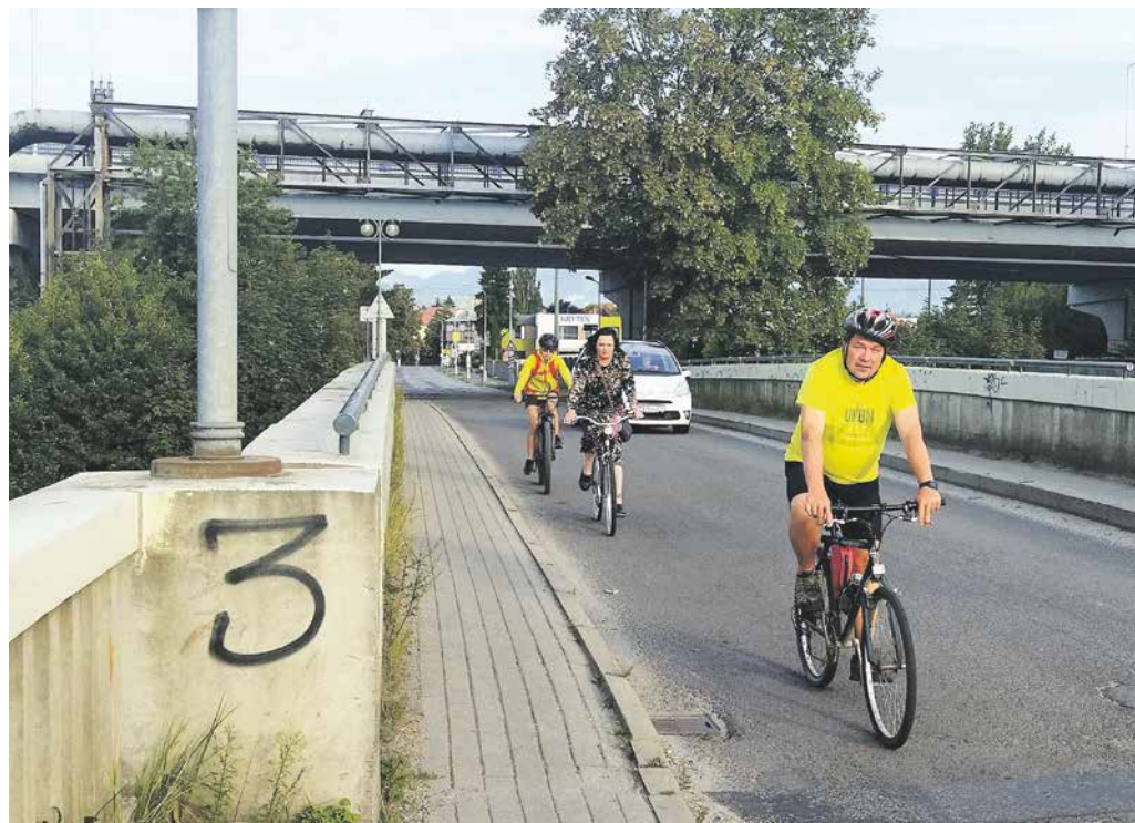
Z kamenného mosta by sa po úprave železničného odstránili chodníky, čím by sa rozšírila cesta pre motoristov. Foto: Roman Kopka
