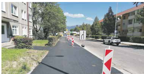
Poškodený chodník na Ul. P. O. Hviezdoslava bol obnovený, pribudlo aj nové stojisko pod smetné nádoby, čoskoro bude náhradná alejová výsadba stromov.
