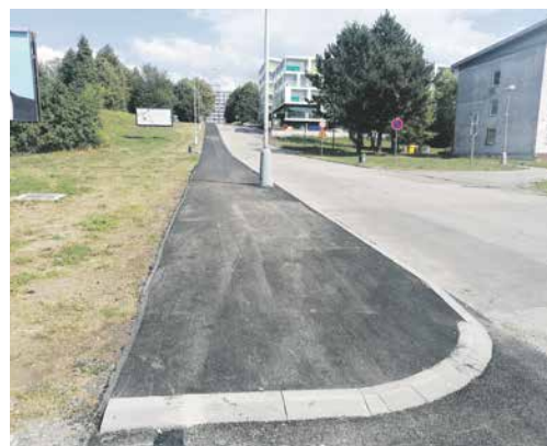
Poškodený chodník na Novomeského ulici bol zrekonštruovaný od plavárne až po internát JL FUK.
