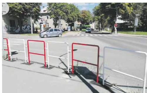
Nové bezpečnostné zábradlie nainštalovali kvôli bezpečnosti chodcov na križovatke ulíc Škultétyho a P. Mudroňa.
