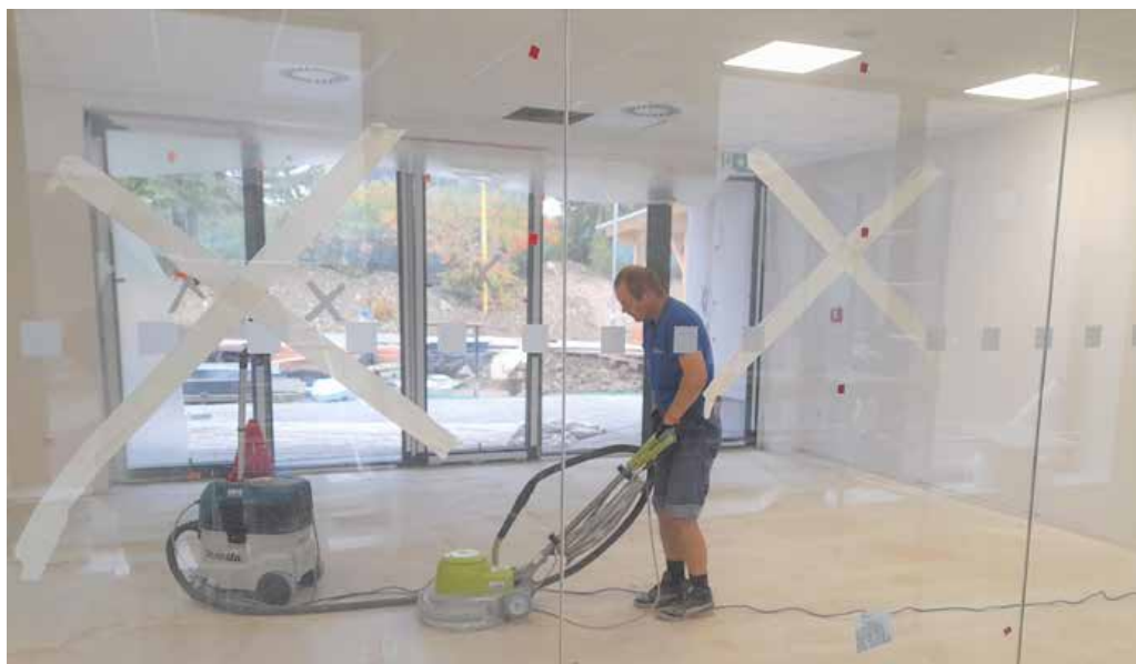
Vo vnútri sa po stavebných prácach už aj všetko čistí a upratuje. Foto: Roman Kopka
