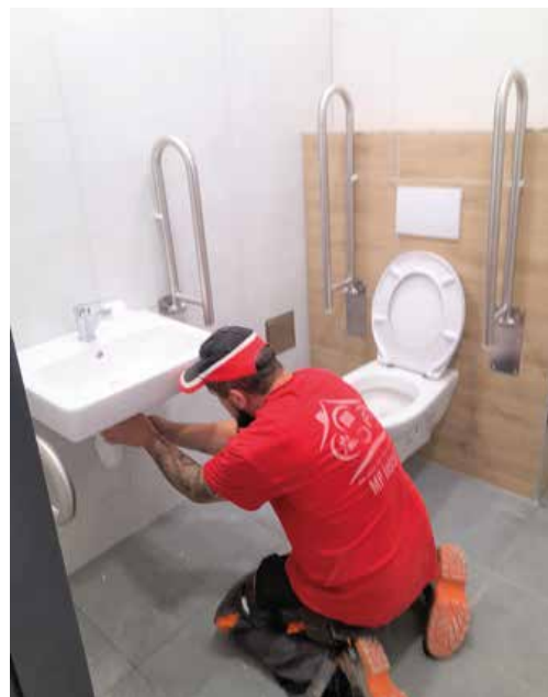
Inštalácia sanity v kúpeľni, ktorej súčasťou bude aj WC. Všetko je prispôbené tak, aby ich mohli využívať ľudia s pohybovými ťažkosťami. Foto: Roman Kopka
