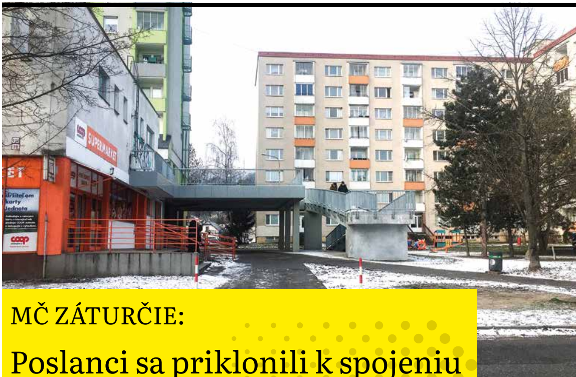
Opravená severná časť pešieho plató v Záturčí. Foto: Viera Legerská
