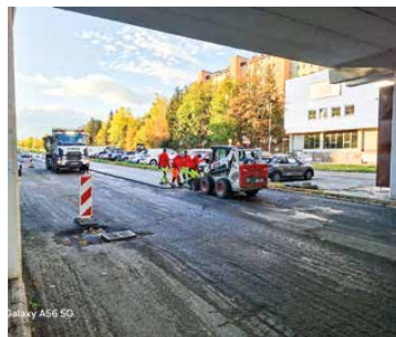
Na Ulici Nade Hejnej na Ľadovni obnovujú asfaltový povrch hlavnej dopravnej tepny sídliska. Foto: Roman Kopka
